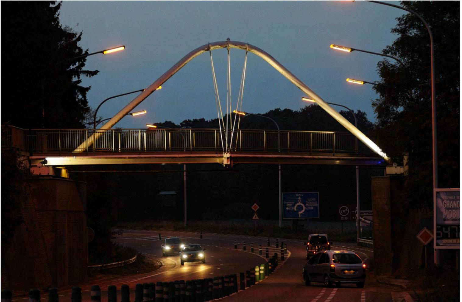
Construite sur la base des anciennes piles du pont de chemin de fer, la passerelle entièrement métallique est constituée d'une seule arche enjambant le RAVeL. Trois tirants de chaque côté soutiennent une seule poutre sur laquelle repose le tablier. Des câbles tenseurs, sous l'ensemble, maintiennent l'écartement de l'arche.
