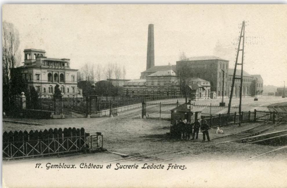
A l'avant-plan, le passage à niveau avec la logette qui abritait le préposé chargé de la fermeture des barrières roulantes.
